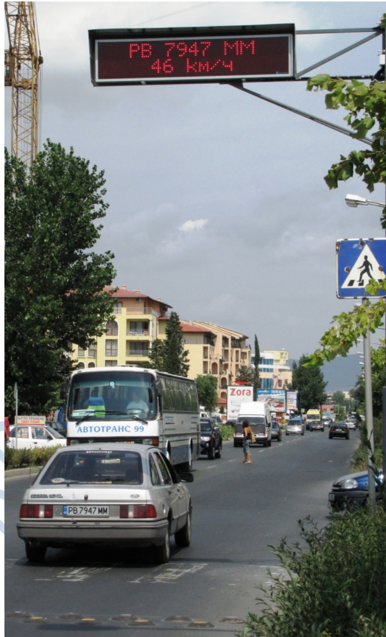
Фиг. 4. Предупредително и информационно LED табло, свързано към SPEEDIX системата 2.4. SPEEDIX-M – Мобилна конфигурация за монтаж в автомобил – предлагат се две разновидности на тази конфигурация според начина на използването ѝ:
